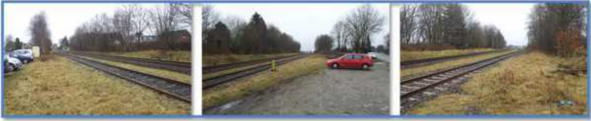
Abbildung 34: Derzeitiges Aussehen möglicher Bahnhaltelpunkt Ohrstedt-Bahnhof
