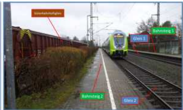
Abbildung 61: Der Bahnhof Jübek - Bild 2
