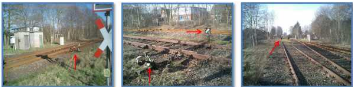
Abbildung 33: Ohrstedt-Bahnhof, 2 Weichen und 1 Prellbock
