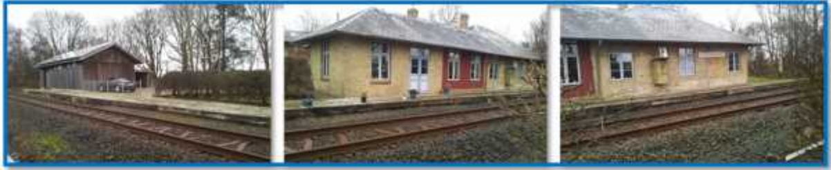
Abbildung 29: Derzeitiges Aussehen Bahnhof Schwesing
