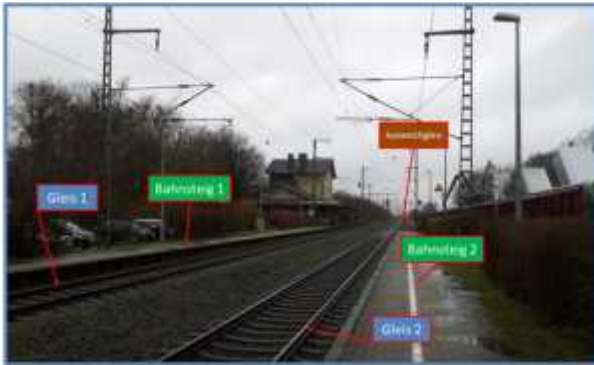
Abbildung 60: Der Bahnhof Jübek - Bild 1
