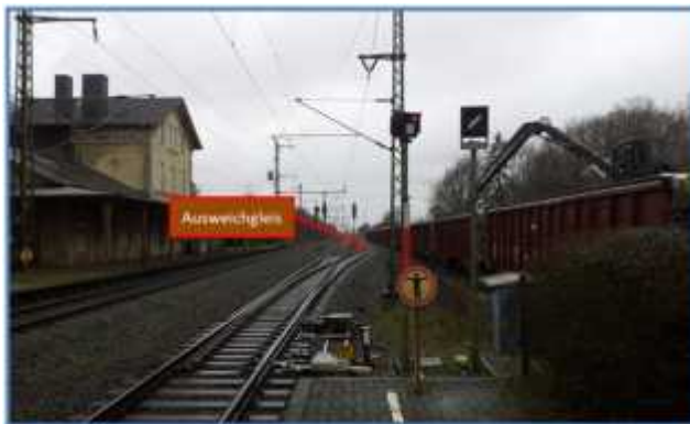
Abbildung 62: Das Ausweichgleis am Bahnhof Jübek
